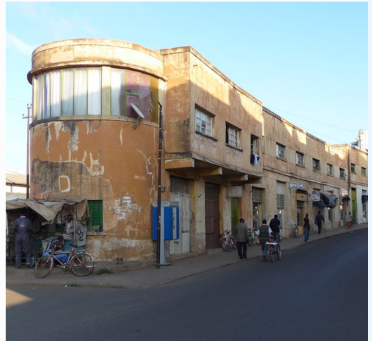
Wohngebäude in Asmara
